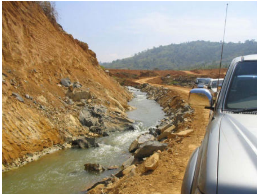
รูปที่ 9-1 แสดงการขุดคลองผันน้ำ
