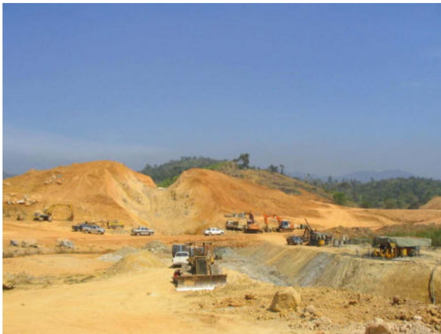
รูปที่ 9-2 แสดงการขุดลอกหน้าดินและขุดร่องแกน
