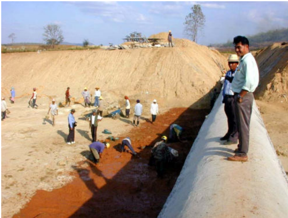
รูปที่ 9-7 แสดงการปูดินเหนียวรองใต้แกนเขื่อน
