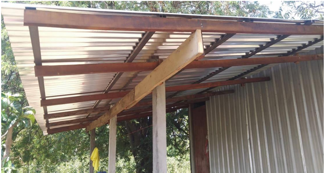
ซ่อมแซมที่อยู่อาศัยของคนพิการ นายมานพ มารศรี หมู่ 15 ตำบลกันจุก
