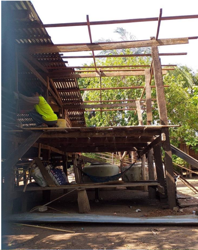
ภาพซ่อมแซมที่อยู่อาศัยของคนพิการ นายบุญส่ง แก้วงาม หมู่ 3 ตำบลกันจุก
