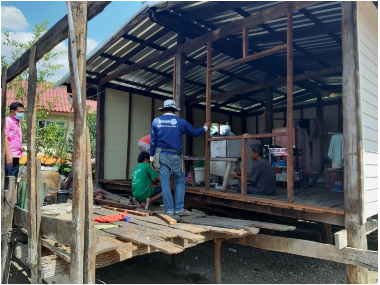
ซ่อมแซมที่อยู่อาศัยของคนพิการ นายอำนาจ ล่วงลือ หมู่ 1 ตำบลกันจุก
